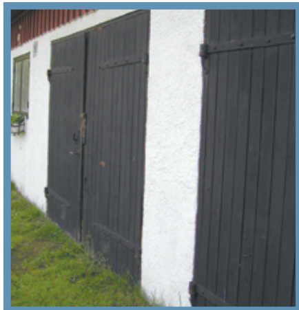
Emulgerad Linoljefärg för fasad och träportar 14 år efter målning
