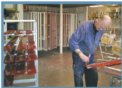
Målning av fönster och fönsterbleck på Bjäresjö Skola, Ystad, Sverige
